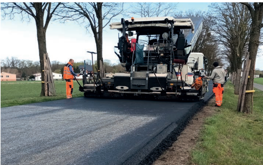
Neue Asphaltdecke auf dem Schafbrückweg
