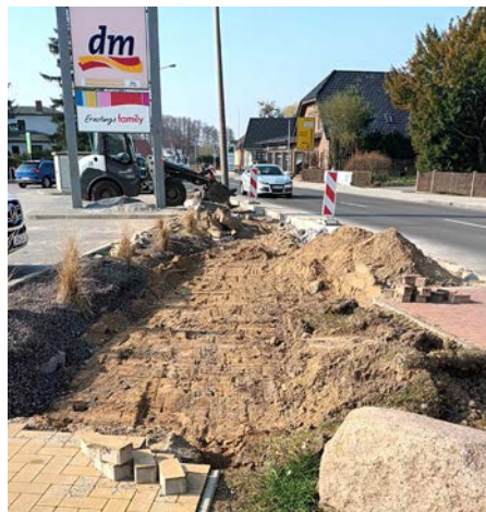
Baustelle in der Belliner Straße
