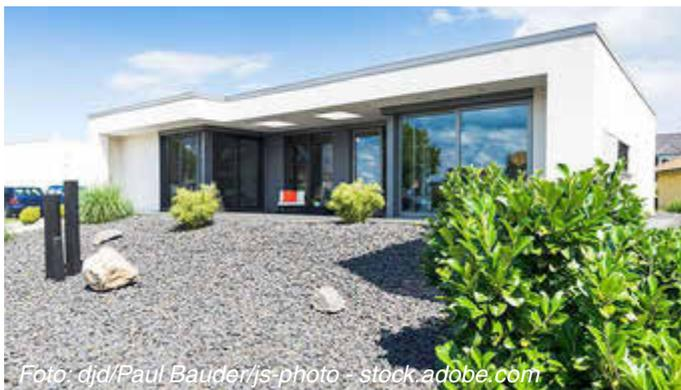
Wohnen auf einer Ebene und bieten mit dem Flachdach, ohne Schrägen in den darunter liegenden Zimmern, einen hohen Nutzwert sowie eine effektive Raumausnutzung. Wichtig bei flachen Dächern ist eine verlässliche Abdichtung sowie eine wirksame Wärmedämmung. Speziell dafür ausgelegte
