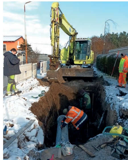
Mitarbeiter der Firma UTS verlegen Entwässerungsleitungen.
