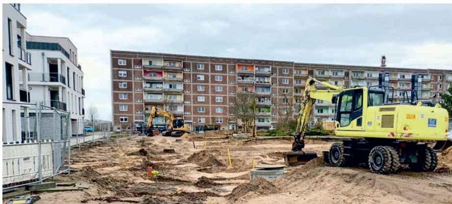
Tiefbauarbeiten in der Isperricher Straße
