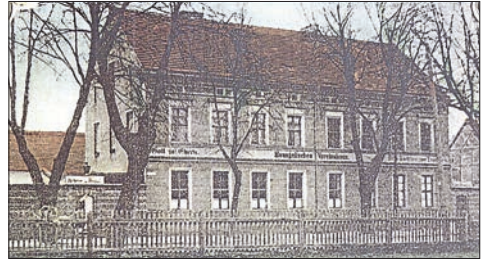
Rettungshaus, Arnimstraße 2, W. Blankenburg
